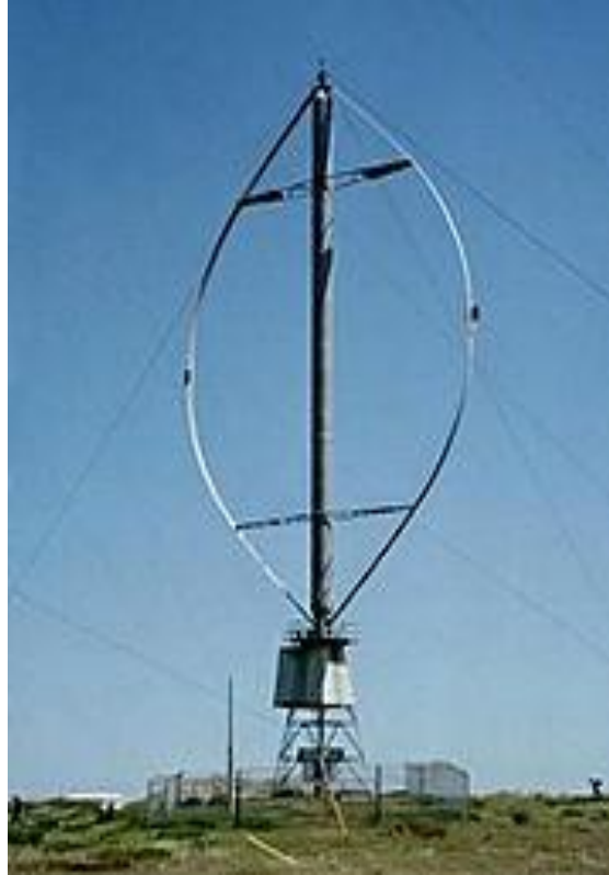
Γράφημα 14: Ανεμογεννήτρια κατακόρυφου άξονα
