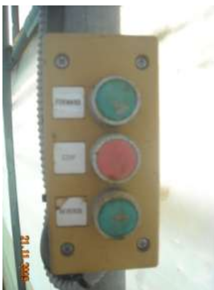
Εικόνα 26: Από εδώ ρυθμίζεται το άνοιγμα των παραθύρων προς τα εμπρός, προς τα πίσω και η παύση λειτουργίας τους.
