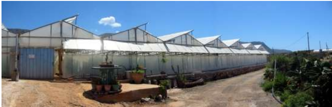
Εικόνα 13: Η πρόσοψη της κλασσικού θερμοκηπίου στο Ελαφονήσι.
