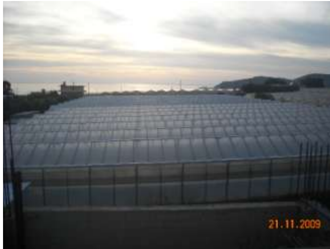
Εικόνα 42: Μεγάλη θερμοκηπιακή μονάδα στην Κουντούρα.
