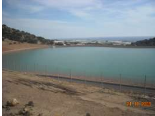
Εικόνα 119: Η λιμνοδεξαμενή της Κουντούρας.
