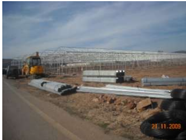
Εικόνα 11: Υπό κατασκευή θερμοκήπιο στην Κουντούρα.
