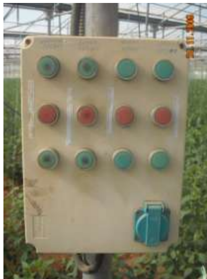
Εικόνα 20: Ο πίνακας ρύθμισης του ανοίγματος των πλαϊνών παραθύρων και των παραθύρων οροφής στο θερμοκήπιο.
