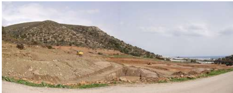
Εικόνα 120: Η λιμνοδεξαμενή Κουντούρας στη διάρκεια των εκσκαφών.
