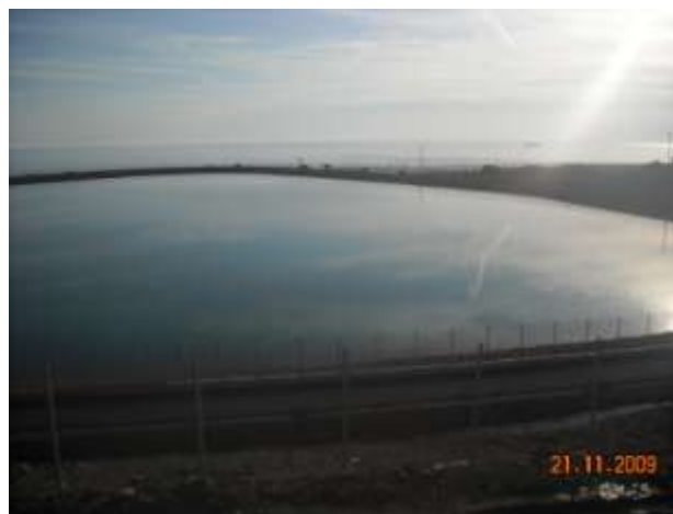
Εικόνα 123: Η δεξιά πλευρά της λιμνοδεξαμενής.
