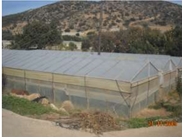
Εικόνα 4: Ξύλινο θερμοκήπιο με κάλυψη από νάilon στην Κουντούρα.
