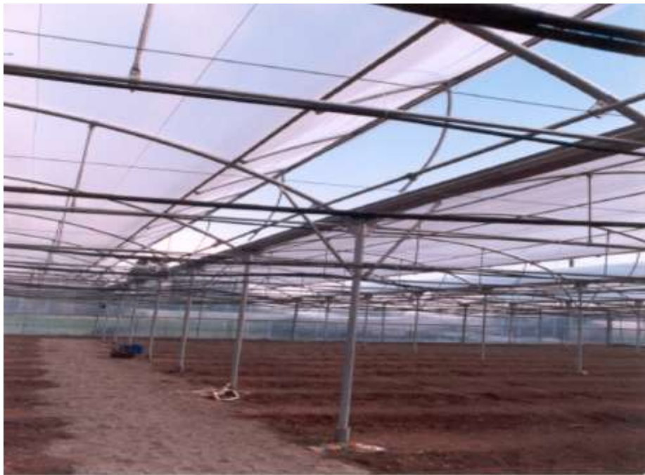
Εικόνα 28: Παράθυρο οροφής θερμοκηπίου.
