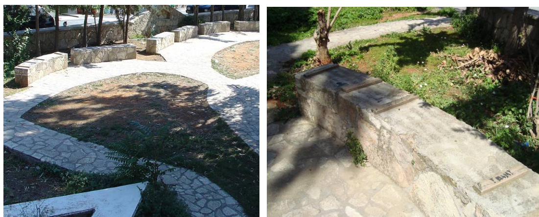
Εικόνες 16 & 17 : Πλακόστρωτοι διάδρομοι & τσιμεντένια παγκάκια
