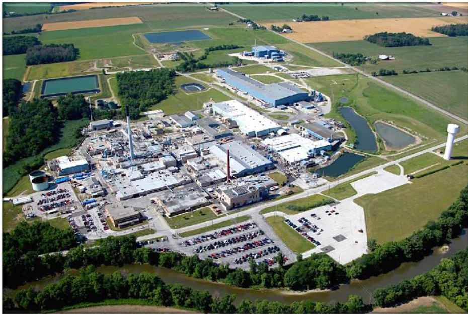
Εικόνα 9. Οι εγκαταστάσεις της Materion Brush Resources, στο Elmore του Οχάιο.
