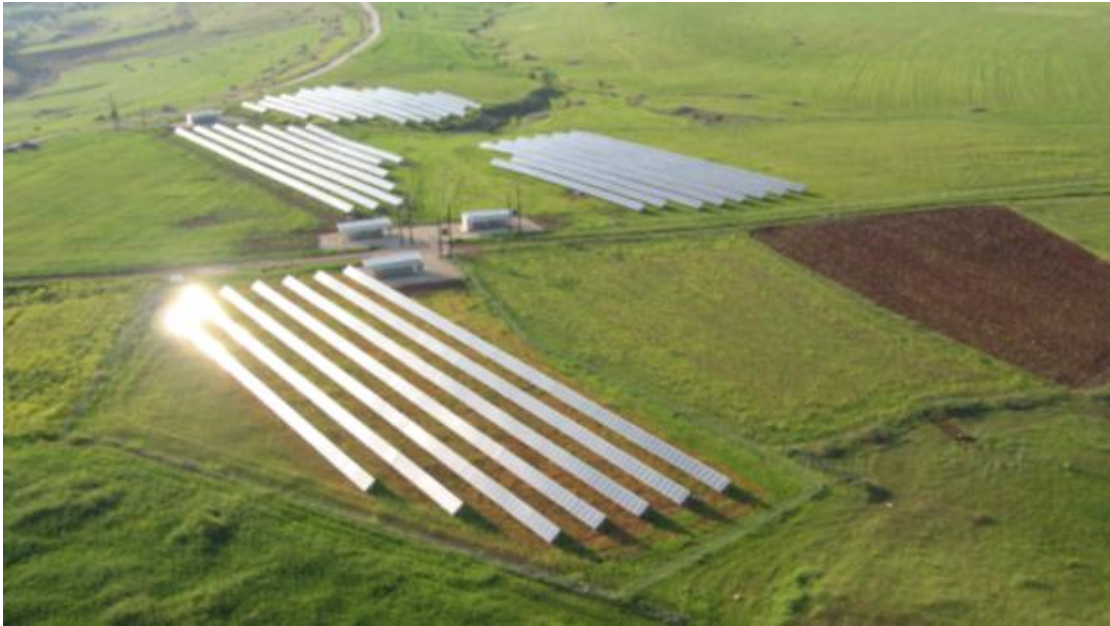
Σχήμα 2.9 Φ/Β πάρκο προσαρμοσμένο σε σταθερή γωνία διασυνδεδεμένο με το δίκτυο
