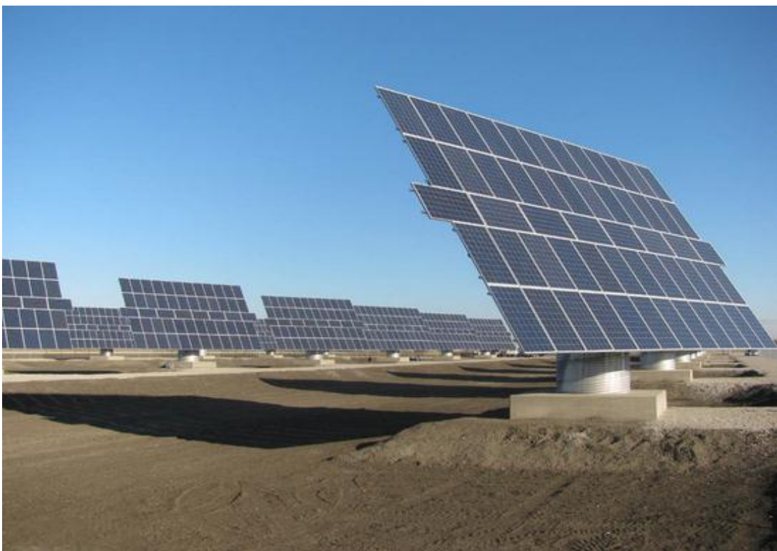
Σχήμα 2.10 Φ/Β πάρκο με σύστημα tracking σε δύο άξονες διασυνδεδεμένο με το δίκτυο
