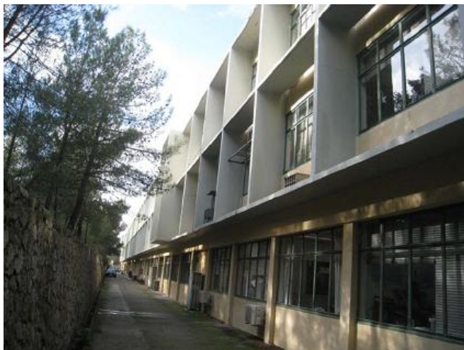
Εικόνα 8. Νότια όψη κτιρίου (συνορεύων τοίχος ύψους 4,5m)
