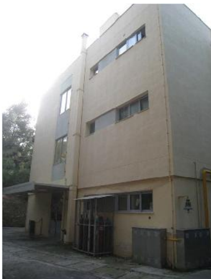
Εικόνα 2. Ανατολική όψη κτιρίου
