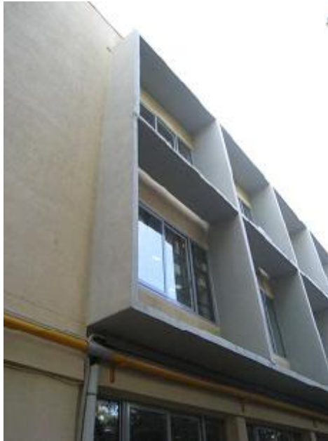
Εικόνα 6. Βόρεια όψη κτιρίου (Ανοίγματα και πρόβολοι σκίασης)
