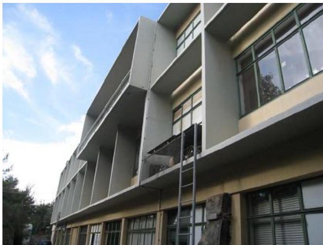
Εικόνα 7. Νότια όψη κτιρίου (Ανοίγματα και πρόβολοι σκίασης)
