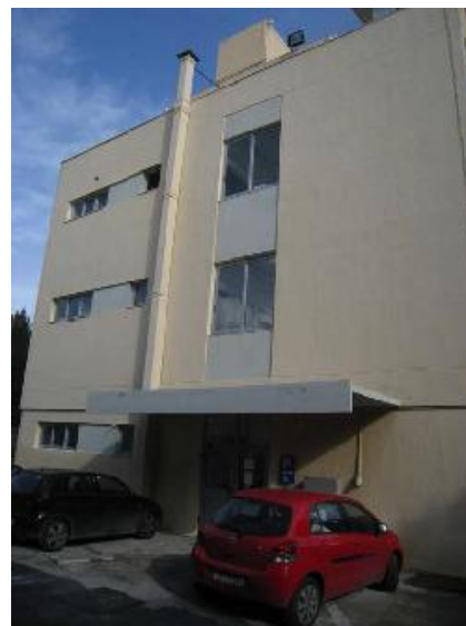
Εικόνα 3. Δυτική όψη κτιρίου
