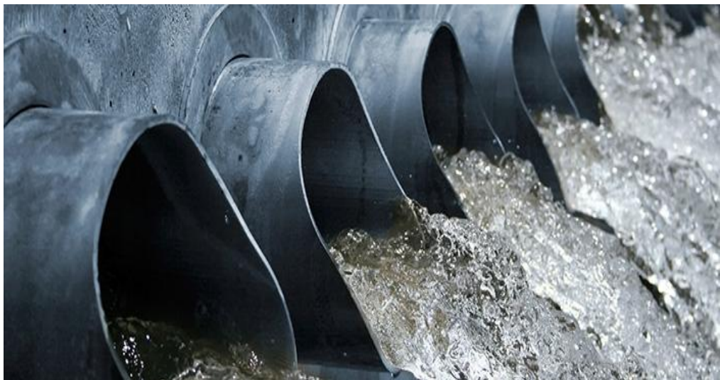
Σχήμα 3: Επεξεργασμένο μαύρο νερό που καταλήγει στον υπόγειο υδροφόρα.
