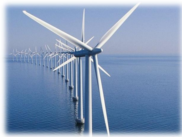
Εικόνα 2 : Θαλάσσιο Αιολικό Πάρκο
