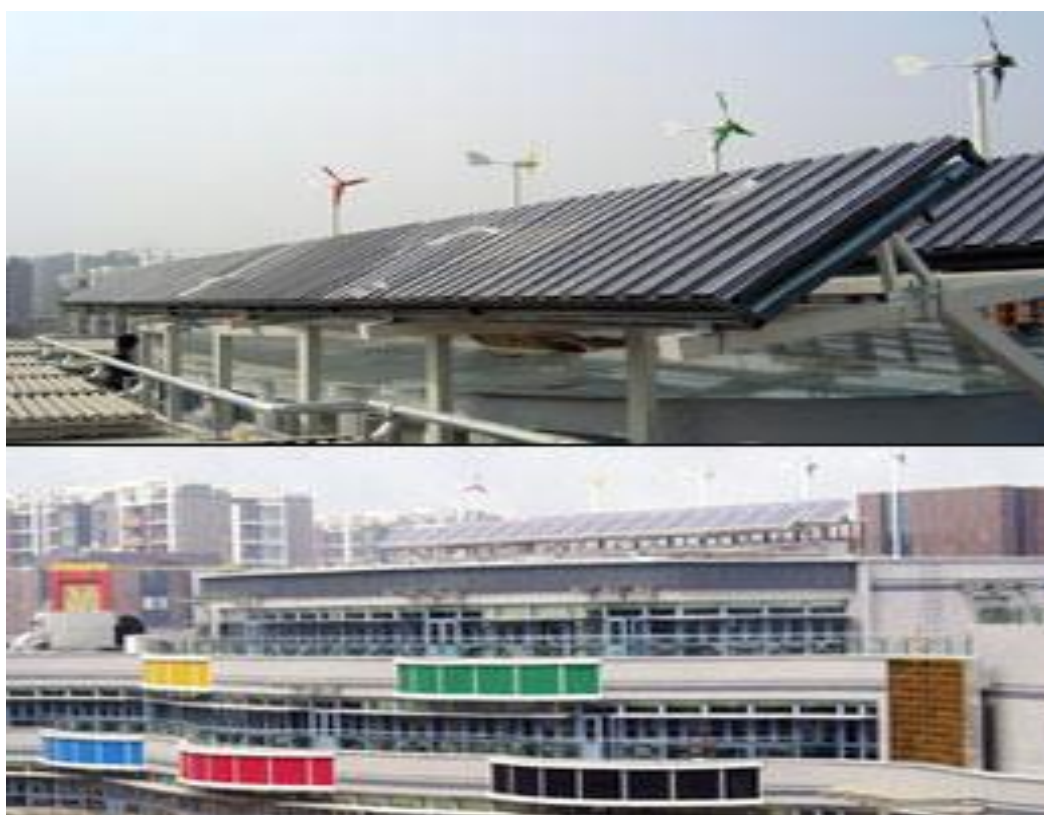
(Εικόνα 25) Στο ολυμπιακό χωριό στην Beijing της Κίνας συνδυασμός PV/T με νερό σε συνδυασμό με ανεμογεννήτριες
