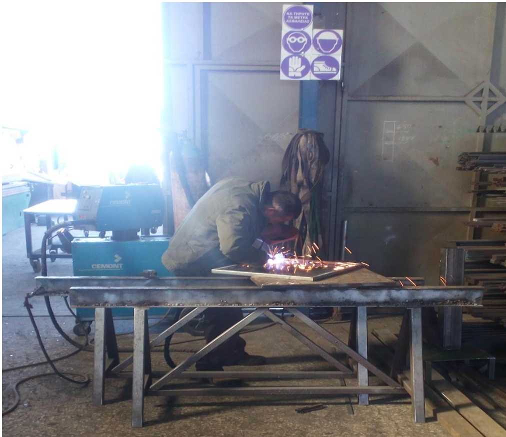
(Εικόνα 37) Ηλεκτροσυγκόλληση των διαφόρων μερών
