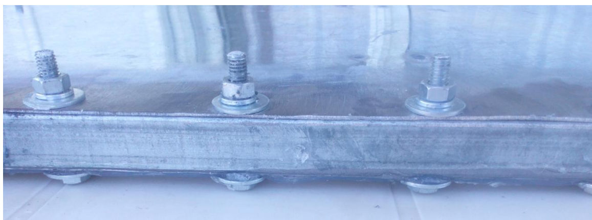
(Εικόνα 43) Πλάγια όψη που φαίνεται η περαστή βίδα, ροδέλα, φωτοβολταϊκό πλαίσιο, θερμικός συλλέκτης, ροδέλα, ροδέλα ασφαλείας, παξιμάδι
