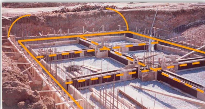
Εικόνα 15: Θεμελιακή γείωση
