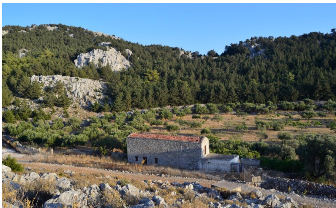
Εικόνα4.3: Τοποθεσία Άνω δεξαμενής
