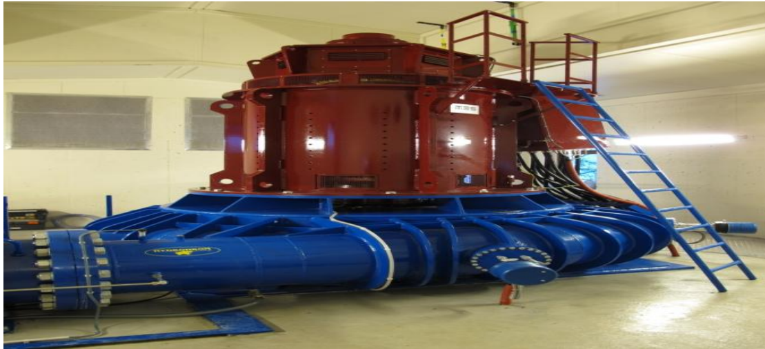
Εικόνα4.19: Υδροστρόβιλος Pelton
