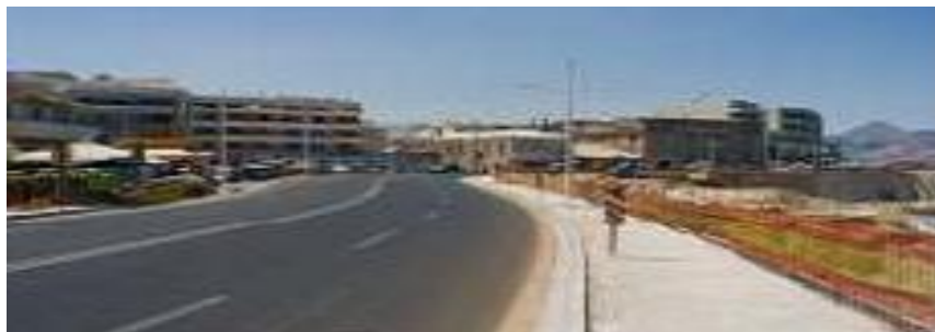
Εικόνα 15: Τα νότια κτίσματα των Αλευρόμυλων στη Σοφοκλή Βενιζέλου έχουν κατεδαφιστεί. Πηγή: Μακρόπουλος Στ.
