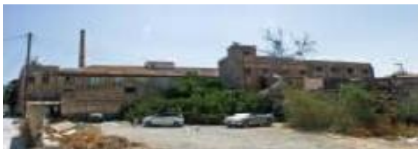
Εικόνα 12: Το Πυρηνελαιουργείο "Αθηνά". Το συγκεκριμένο κτίσμα προορίζεται να στεγάσει υπηρεσίες του Δήμου. Πηγή: Μακρόπουλος Στ.
