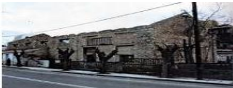
Εικόνα 14: Το Σαπωνοποιείο. Το συγκεκριμένο κτίσμα είχε προταθεί για διατήρηση αλλά παρόλα αυτά κατεδαφίστηκε και στη θέση του υπάρχει πλέον μια πολυκατοικία. Πηγή: Ο.Ε. ΤΕΕ/ΤΑΚ, 1996
