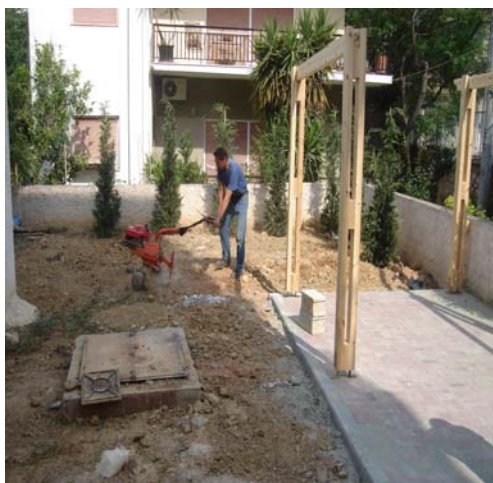
Εικ.47 Κήπος πριν την κατασκευή
