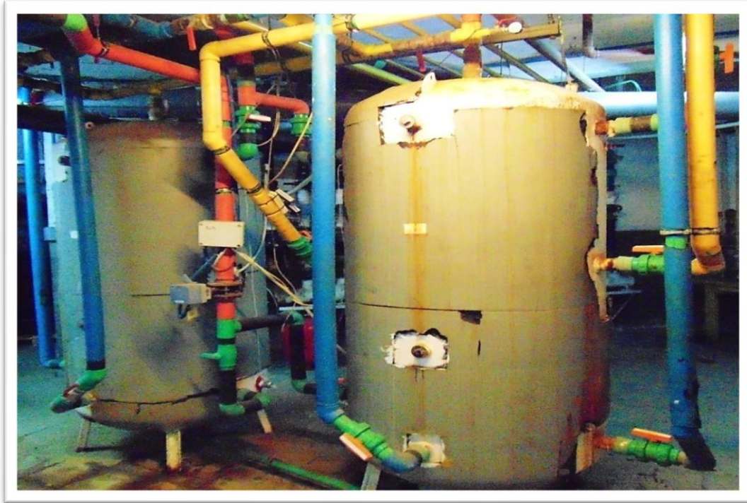
Εικόνα 36: Τα τελικά θερμοδοχεία-μπόιλερ στο κεντρικό μηχανοστάσιο
