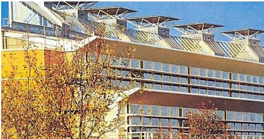
Εικόνα 2.12. Καμινάδα αερισμού σε κτίριο γραφείων στο Cambridge (Ionica).
