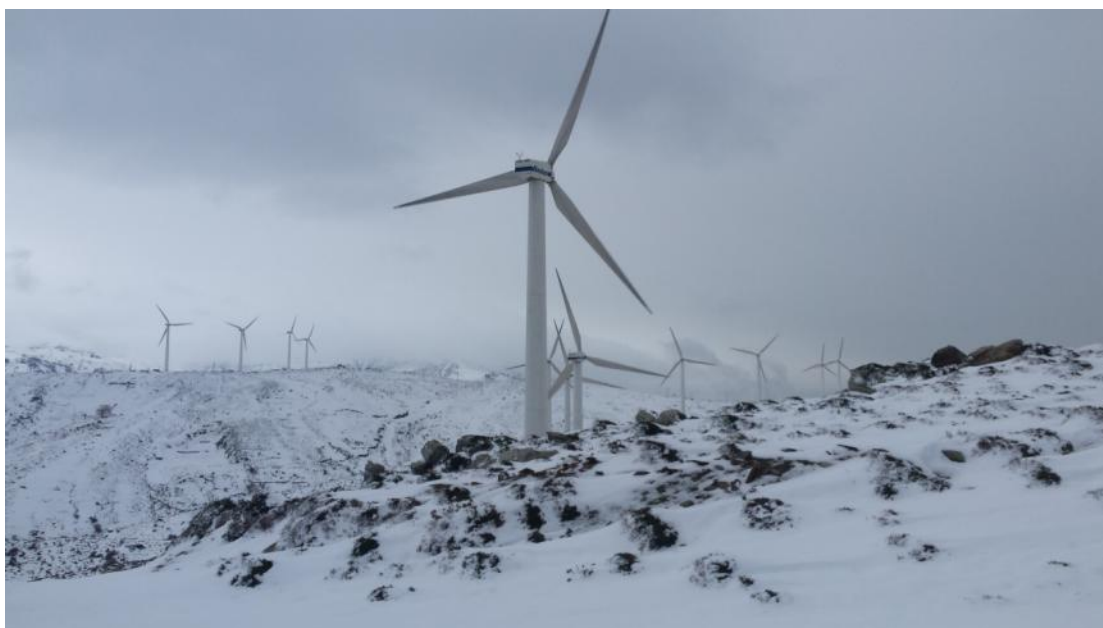
Εικόνα 1.2.1 :Ανεμογεννήτρια οριζόντιου άξονα
