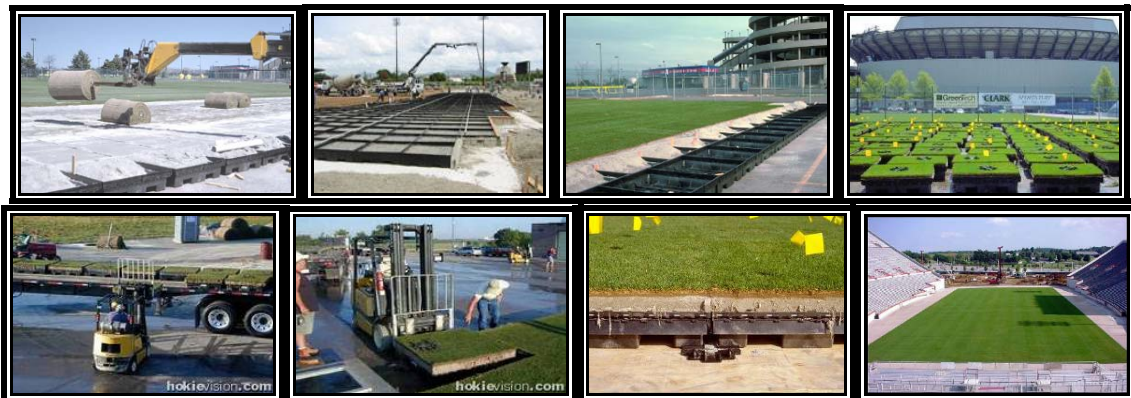
Εικόνα 16. Προετοιμασία του συστήματος GreenTech ITM™ σε βοηθητικό χώρο εξωτερικά του γηπέδου και τρόπος μεταφοράς και τοποθέτησης των παλετών στο εσωτερικό του γηπέδου ( www.greentechitm.com ).
