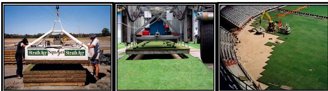
Εικόνα 20. Εξειδικευμένο μηχανήμα μεταφοράς πλακών και διαδικασία εγκατάστασης πλακών ( www.strathayr.com ).
