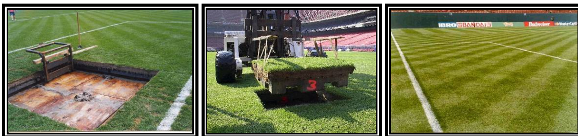
Εικόνα 17. Εργασίες απομάκρυνσης και αντικατάστασης καταπονημένου τμήματος χλοοτάπητα στη μικρή περιοχή σε γήπεδο ποδοσφαίρου ( www.greentechitm.com ).
