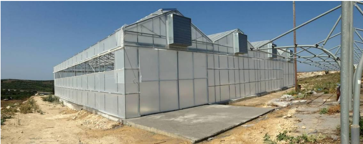
Γενική άποψη πρόσοψης μονάδας
