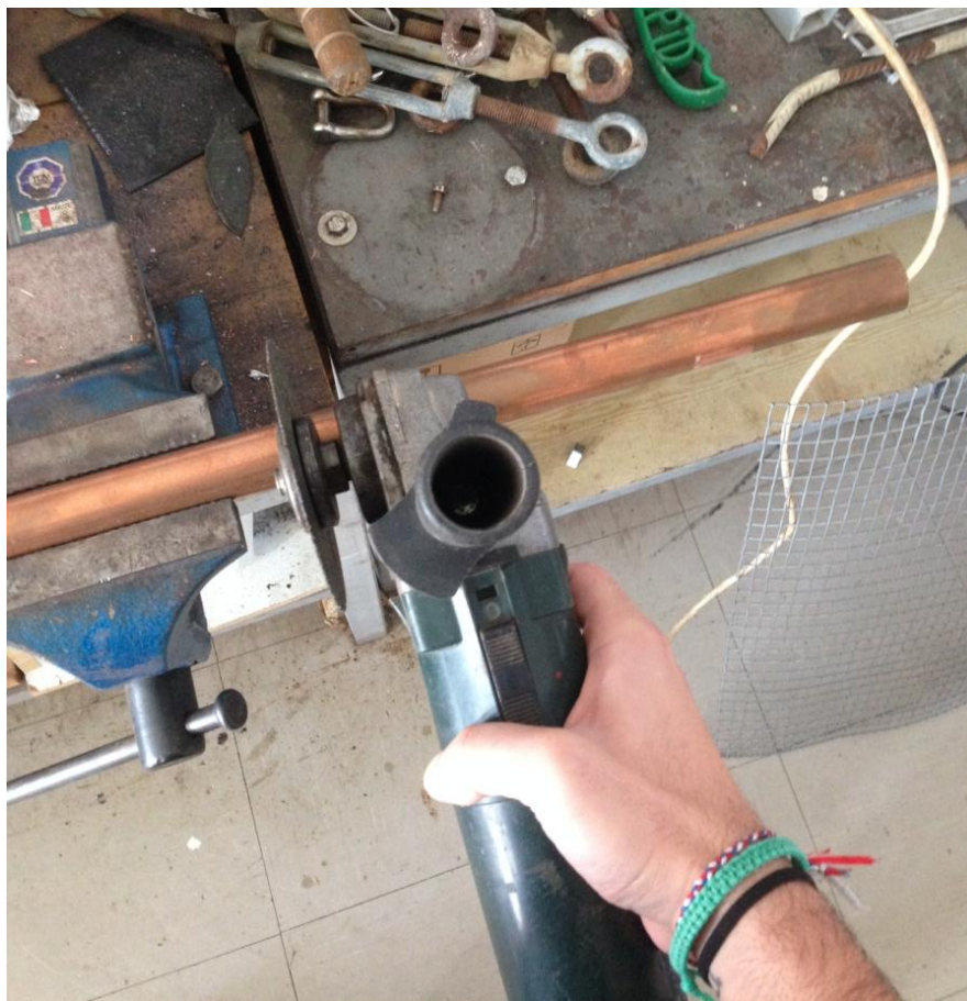
Εικόνα 28: Κοπή σωλήνων στις κατάλληλες διαστάσεις.
