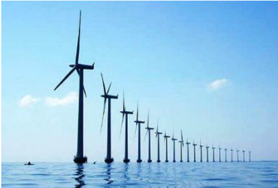
Σχήμα 2.3: Υπεράκτιο αιολικό πάρκο 37 .
