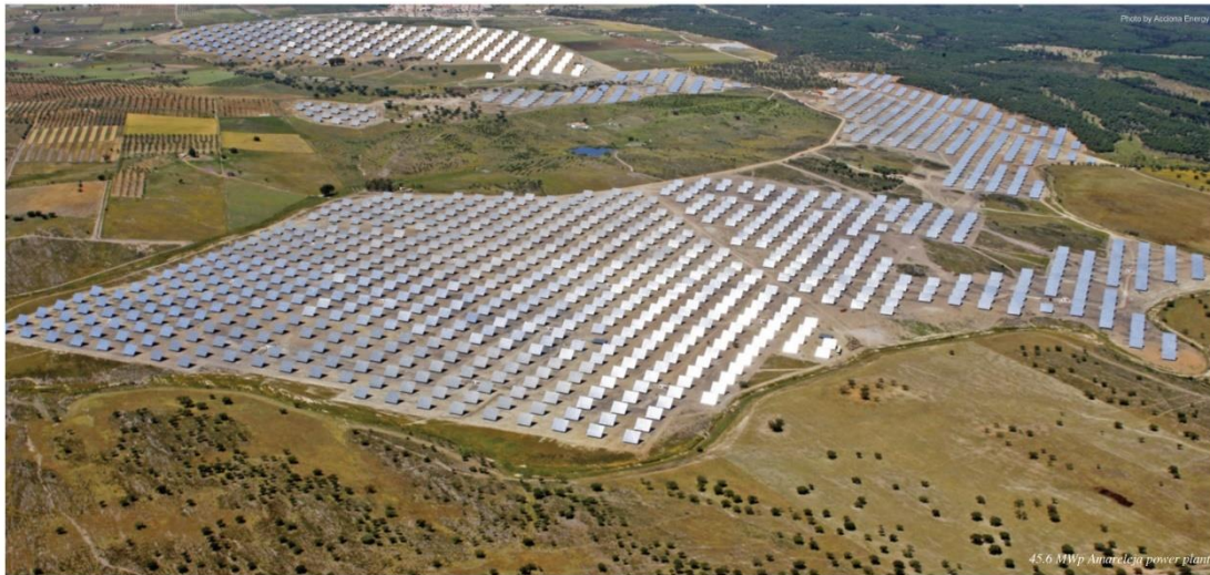
Σχήμα 1.5: Φωτοβολταϊκός σταθμός Amareleja, Πορτογαλία 19
