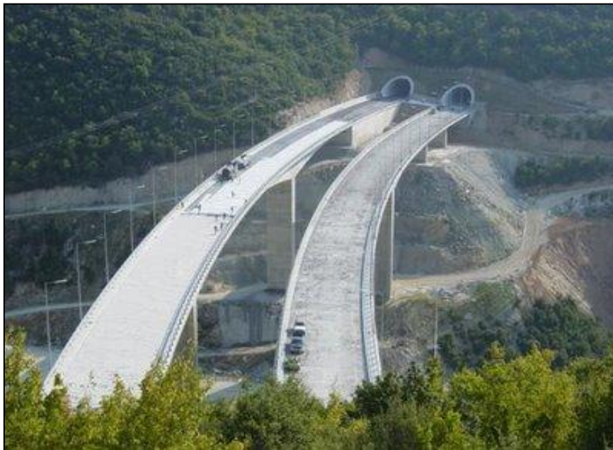
Εικόνα 1.1: Κατασκευή οδικού άξονα της Εγνατίας Οδού
