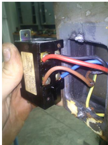
Εικόνα 31. Εξαγωγή καλωδιώσεων και διακοπών από τον κορμό.
