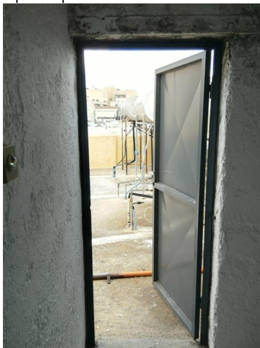
Εικόνα 55 Πόρτα προθαλάμου που οδηγεί στην ταράτσα
