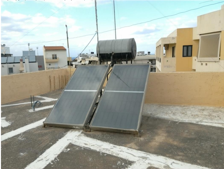
Εικόνα 48 Μονός ηλιακός θερμοσίφωνας ταράτσας
