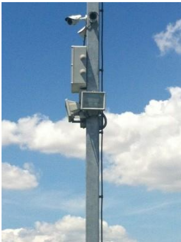
Εικόνα 59 Τοποθέτηση προβολέων κάτω από τις κάμερες
