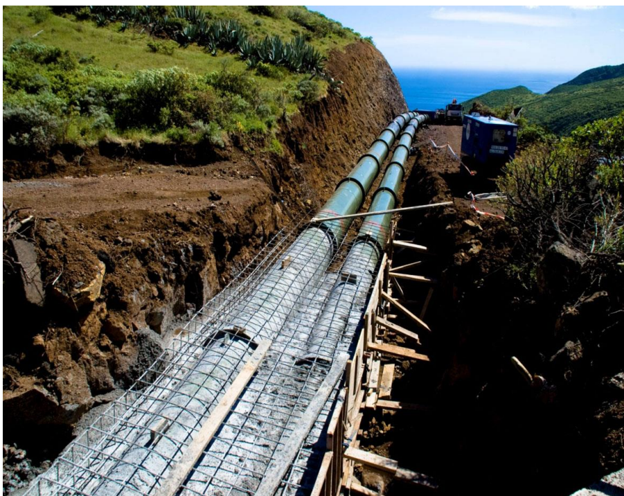
Εικόνα 3.1: Εγκατάσταση επί της επιφάνειας του εδάφους των αγωγών διασύνδεσης των δεξαμενών στο υπό κατασκευή αναστρέψιμο υδροηλεκτρικό στο νησί El Hierro των Κανάριων Νήσων.
