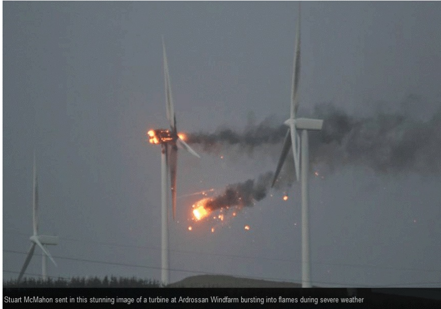
Εικόνα 52: Φωτιά στον έλικα Ανεμογεννήτριας cxxxiv
