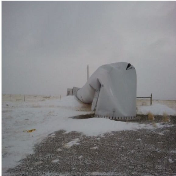
Εικόνα 37: Ο πύργος ανεμογεννήτριας που έχει λυγίσει έπειτα από χιονόπτωση cxiii
