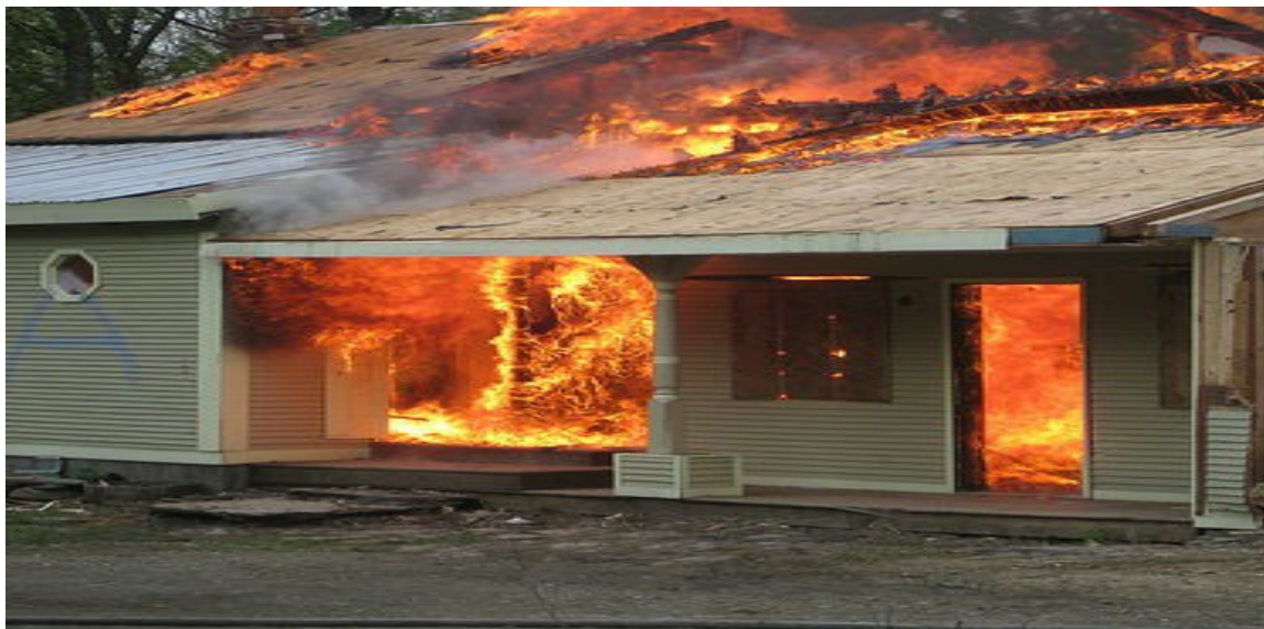
Εικόνα 49: Πυρκαγιά σε οικία με εγκατεστημένα Φ/Β
