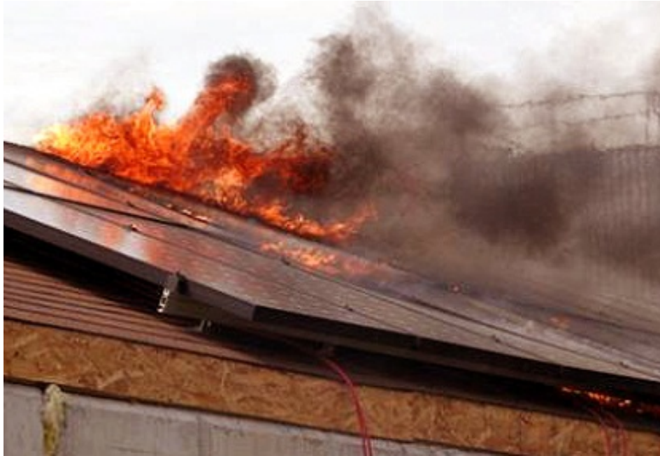
Εικόνα 50: Αποτέλεσμα φωτιάς ενός Φ/Β μετά από κεραυνό cxvii
