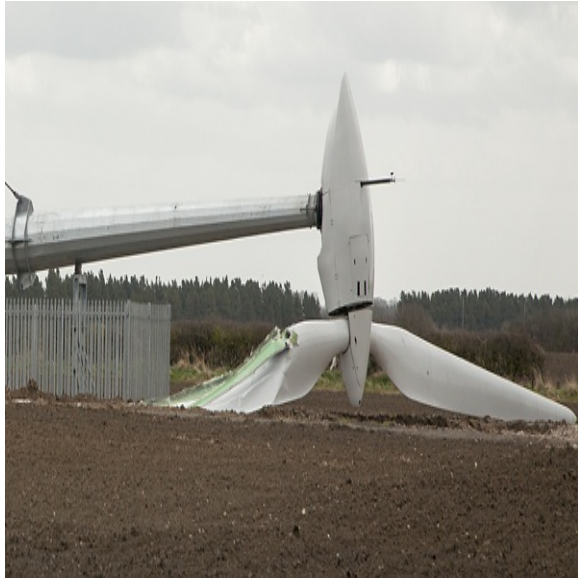
Εικόνα 46: Ανεμογεννήτρια η οποία έχει πέσει έπειτα από ισχυρούς ανέμους cxxvii
