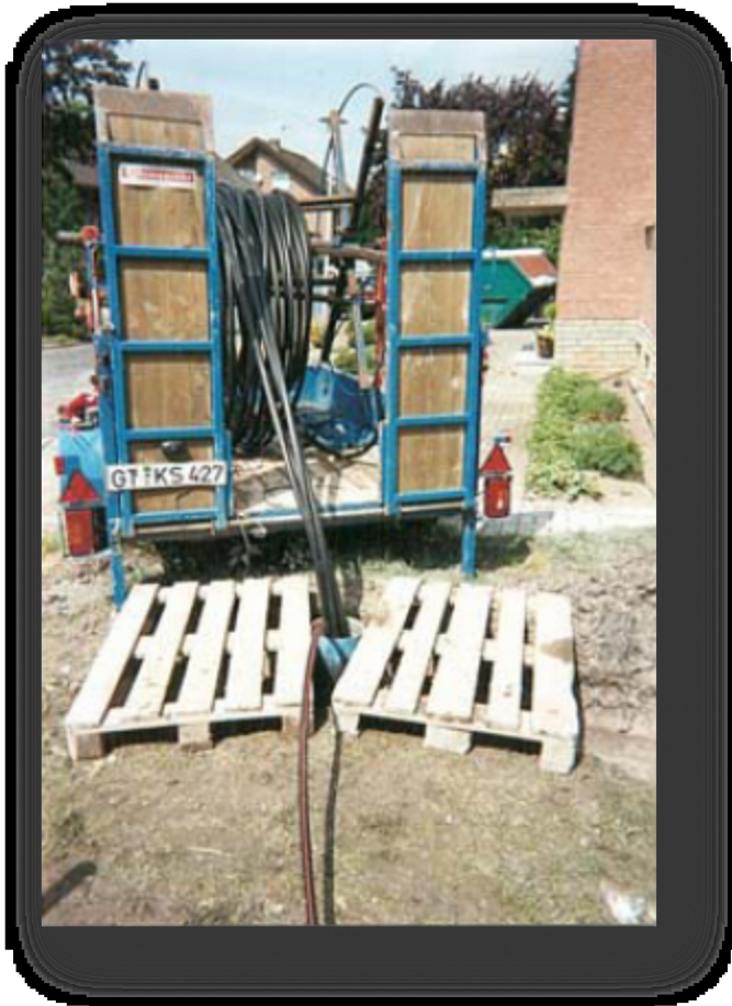
Εικόνα 27:Κατακόρυφη κατασκευή κατακόρυφων καλωδίων στη γεωθερμία
