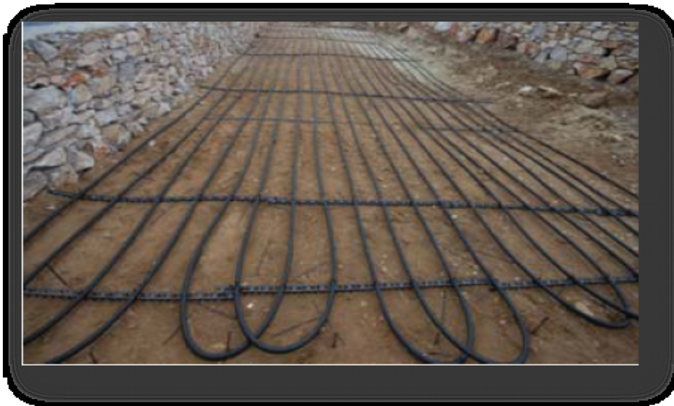
Εικόνα 26: Τοποθέτηση οριζόντιων γεωεναλλακτών
