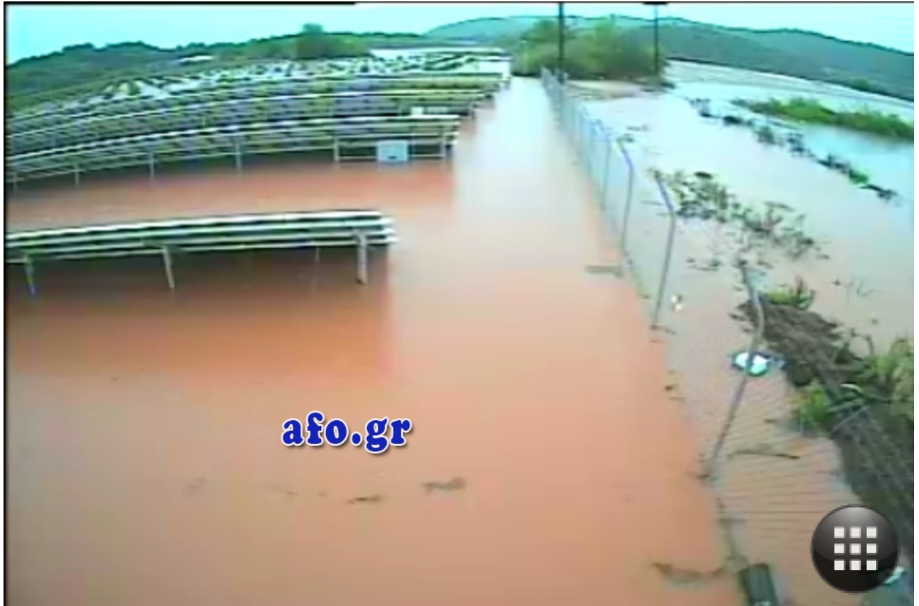
Εικόνα 40: Αποκλεισμένη περιοχή με φωτοβολταϊκά λόγω πλημμύρας cxviii
