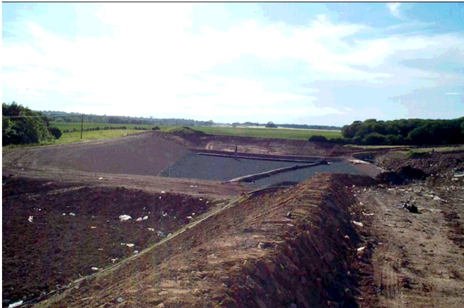
Εικόνα 18. Αποστραγγιστικό σύστημα με αδρανή υλικά
