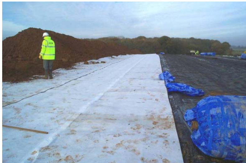
Εικόνα 16. Κάλυψη για ελαχιστοποίηση της εισόδου νερού
