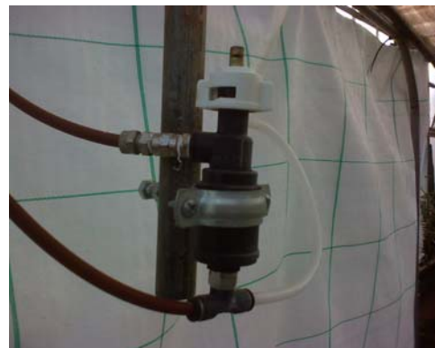
Εικόνα 4. Σύστημα τεχνητής ομίχλης (fog system).
