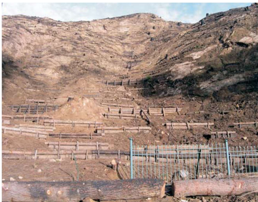
Σχήμα 21. Προστασία παλαιάς γεωλίσθησης στη νότια πλευρά του Κρόνιου λόφου, με την κατασκευή κορμοφραγμάτων και κορμοδεμάτων
