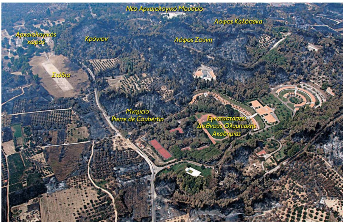
Σχήμα 7. Εναέρια φωτογραφία του προς αποκατάσταση χώρου της Ολυμπίας, δύο μέρες μετά την πυρκαγιά του έτους 2007.
