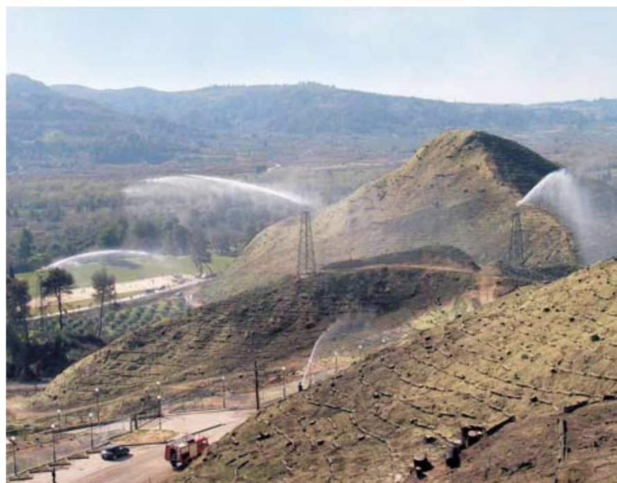
Σχήμα 26. Άρδευση των χώρων εφαρμογής της υδροσποράς στο χώρο της Διεθνούς Ολυμπιακής Ακαδημίας και στο λόφο Ζούνη, με τη χρήση των πυλώνων
