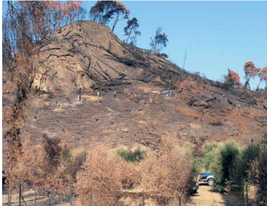
Σχήμα 13. Υλοτομία καμένου ιστάμενου ξυλώδους όγκου και κατασκευή αντιδιαβρωτικών έργων στην ανατολική πλευρά του Κρόνιου λόφου (19-9-2007).
