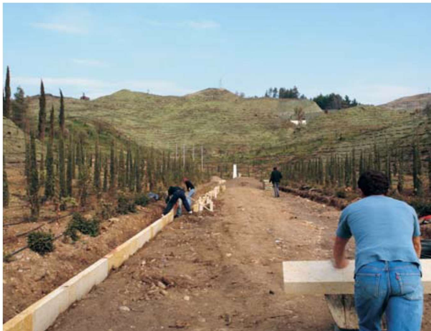
Σχήμα 28. Κατασκευή ρείθρων από κογχυλιάτη λίθο στο διάδρομο επισκεψιμότητας του μνημείου P. de Coubertin (28-2-2008).
