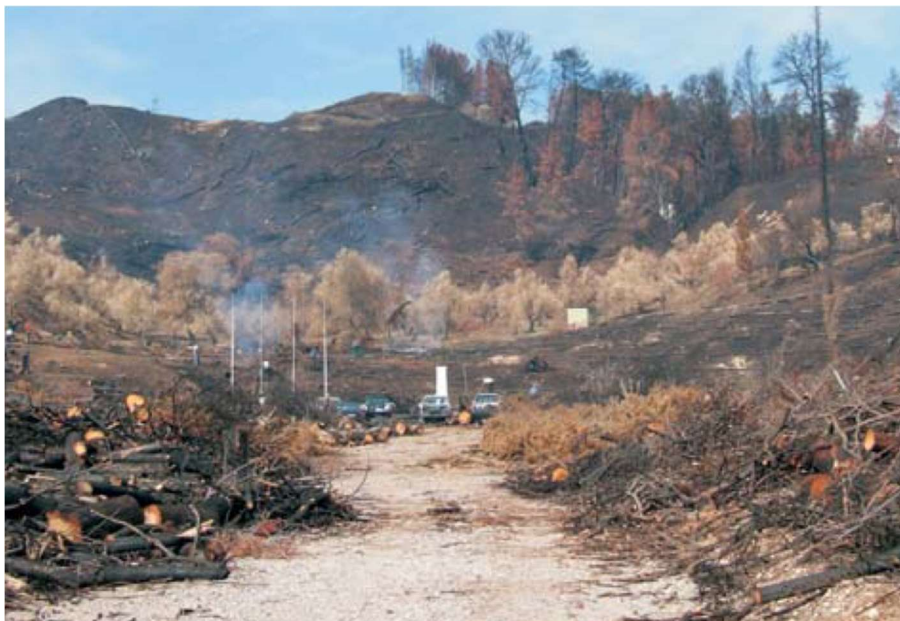
Σχήμα 12. Υλοτομικές εργασίες και κατασκευή κορμοδεμάτων στο μνημείο P. de Coubertin. Διακρίνονται τα καμένα ελαιόδενδρα και στο δεύτερο επίπεδο ο χώρος της Διεθνούς Ολυμπιακής Ακαδημίας. (23-10-2007).
