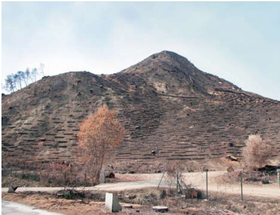
Σχήμα 15. Γενική άποψη της νοτιοανατολικής και ανατολικής πλευράς του Κρόνιου λόφου στη φάση ολοκλήρωσης των αντιδιαβρωτικών έργων
