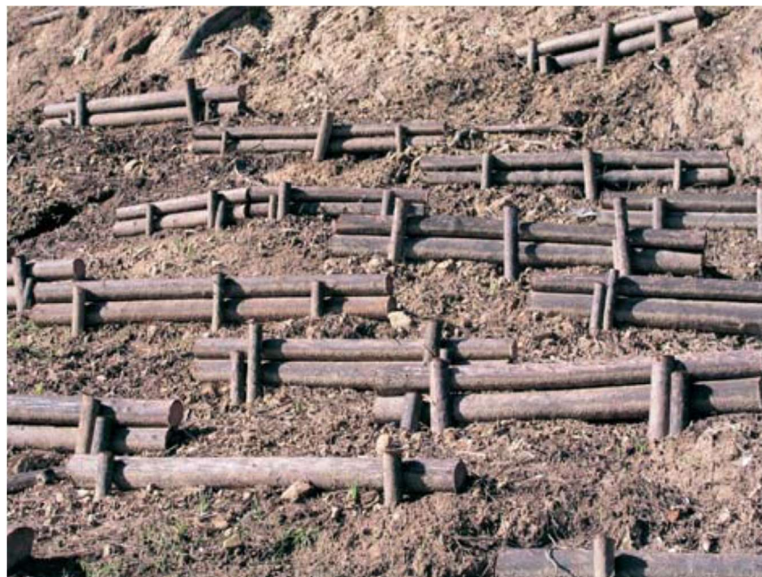
Σχήμα 14. Λεπτομέρεια κατασκευής δίσειρων κορμοδεμάτων (26-11-2007).
