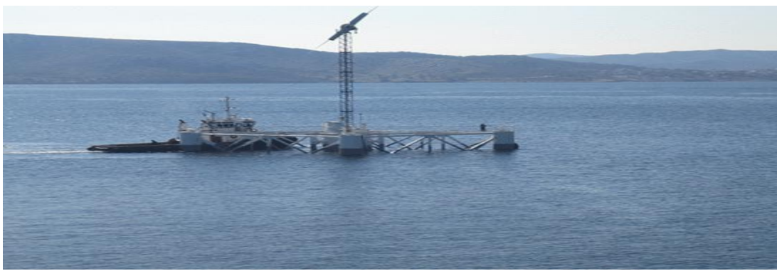
Εικόνα 8. Πλωτή Μονάδας Αφαλάτωσης Υδριάδας
