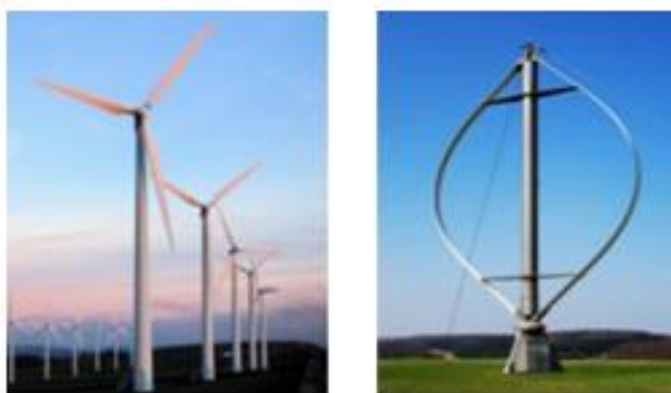
Εικόνα 2.1.1: Τύποι Ανεμογεννητριών –οριζόντιου άξονα αριστερά και κάθετου άξονα δεξιά ( www.slideshare.net )
