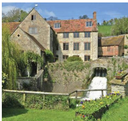
Εικόνα 2.4.3: Μικρό υδροηλεκτρικό σε τουριστικό κατάλυμα (WTO, 2017)
