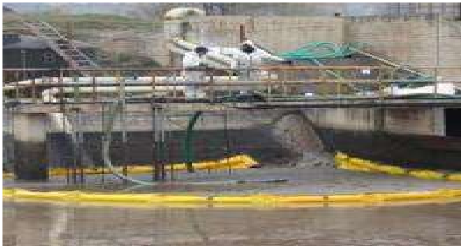
Σχήμα 9. Φράγμα τύπου κουρτίνας [Πηγή: www.oilspillresponse.gr]
