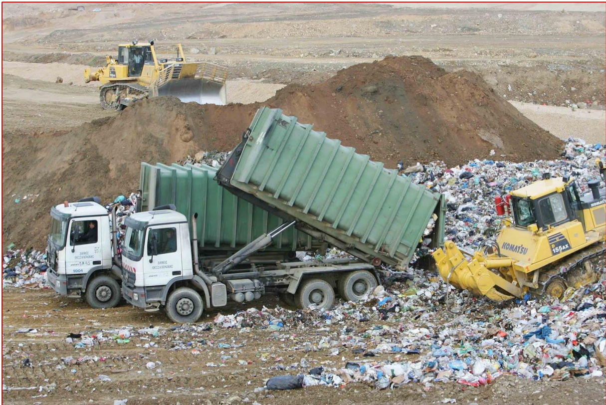
Εικόνα 3.15: Φωτογραφία από ΧΥΤΑ, διαδικασία εναπόθεσης απορριμμάτων σε λωρίδες
