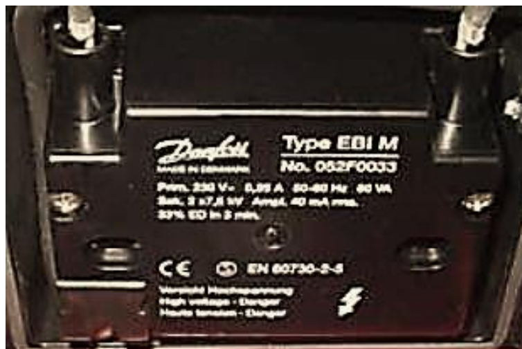
Εικόνα 2.1.10: Μετασχηματιστής καυστήρα
