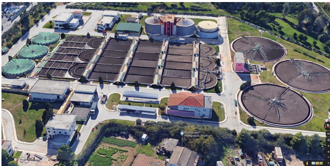
Εικόνα 2 Μονάδα επεξεργασίας λυμάτων από ψηλά. (Google maps, 2020). Η παρούσα εικόνα και η εικόνα του εξωφύλλου αποτελούν παράδειγμα παρόμοιας μονάδας και καμία άλλη σχέση δεν έχουν με την εργασία αυτή
