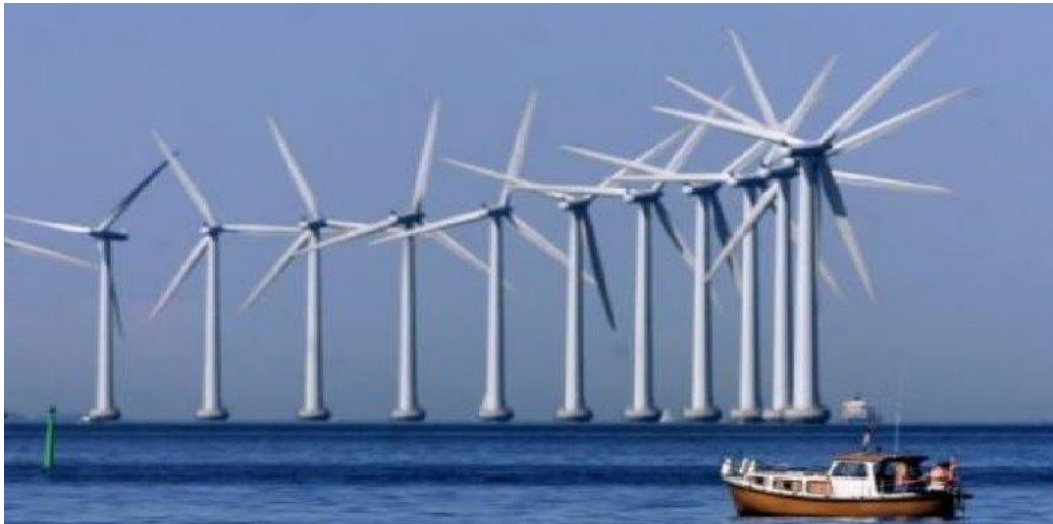
Εικόνα 4.3 Θαλάσσιο αιολικό πάρκο
