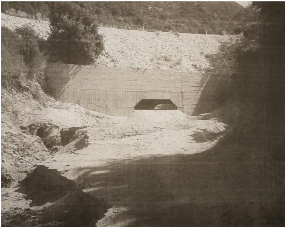
Φωτογραφικό υλικό από τη φάση κατασκευής του έργου
