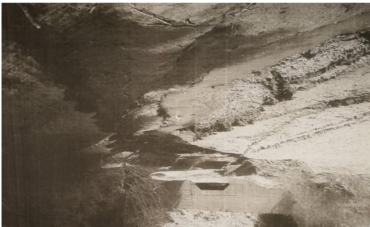
Φωτογραφικό υλικό από τη φάση κατασκευής του έργου
