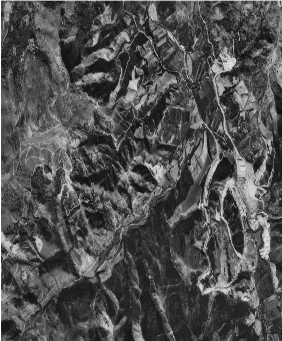
Αεροφώτογραφια του φραγματος
