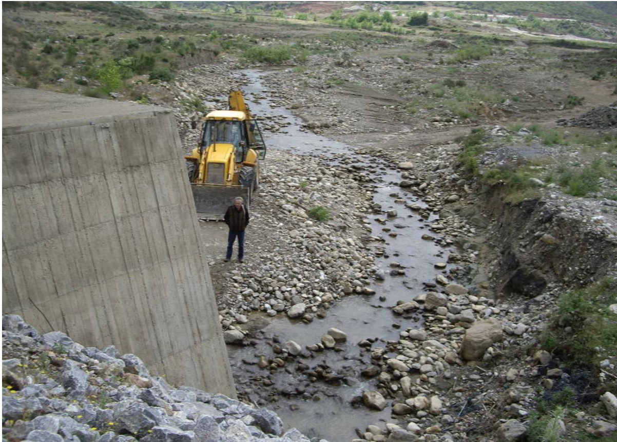
Άποψη του έργου κατά τη διάρκεια των εργασιών
