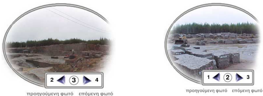
Εικόνες 3.2, 3.3: Μέτωπο εξόρυξης λατομείου γρανίτη.
