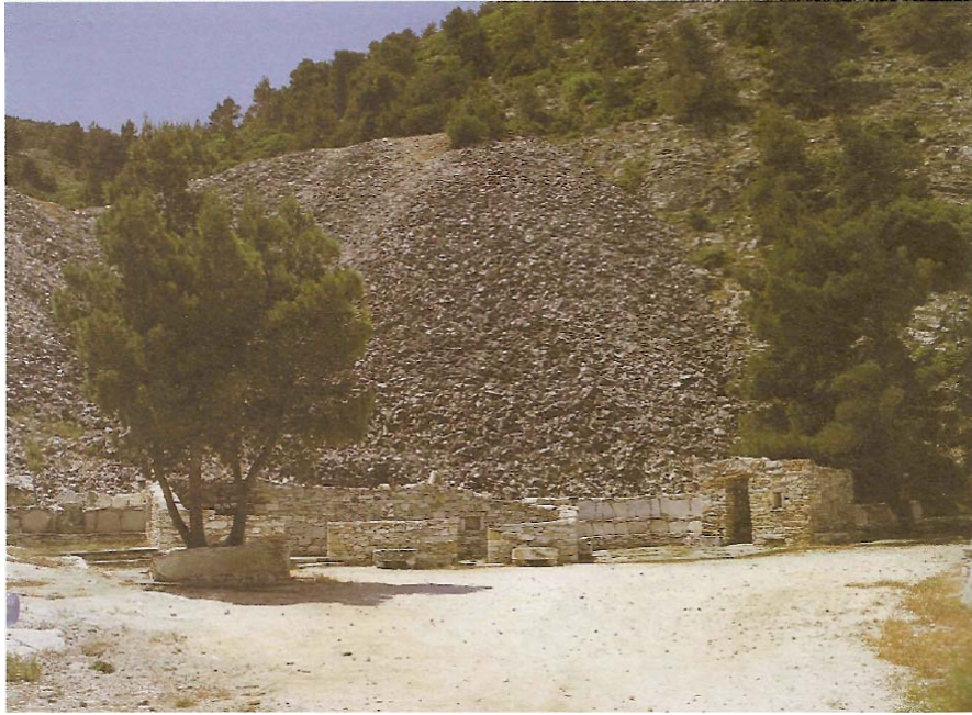
Εικόνα 2.10: Λιθόκτιστος τοίχος αντιστήριξης και τοιχεία.
