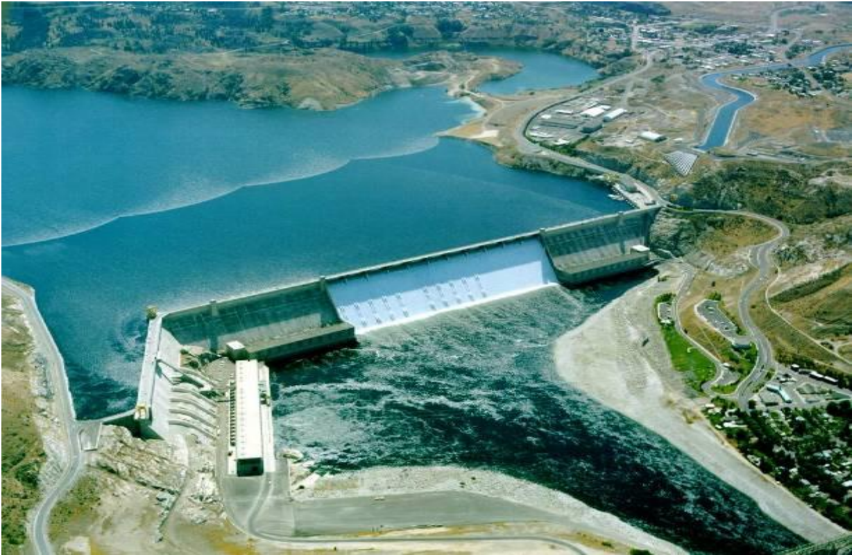
Εικόνα 3.3 : Τεχνητός ταμιευτήρα αποθήκευσης νερού
