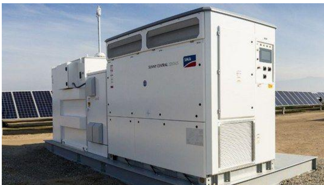
Εικόνα No.5 – Κεντρικός αντιστροφέας Sunny Central
