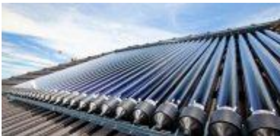
Εικόνα 2.3.3.2 Ηλιακό πλαίσιο με σωλήνες κενού
