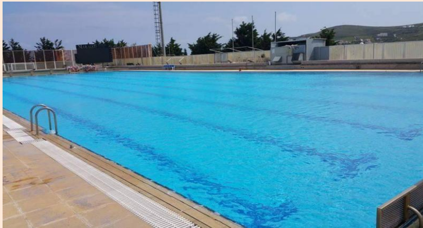
Εικόνα 30: Πισίνα υπερχείλισης με περιμετρικό κανάλι
