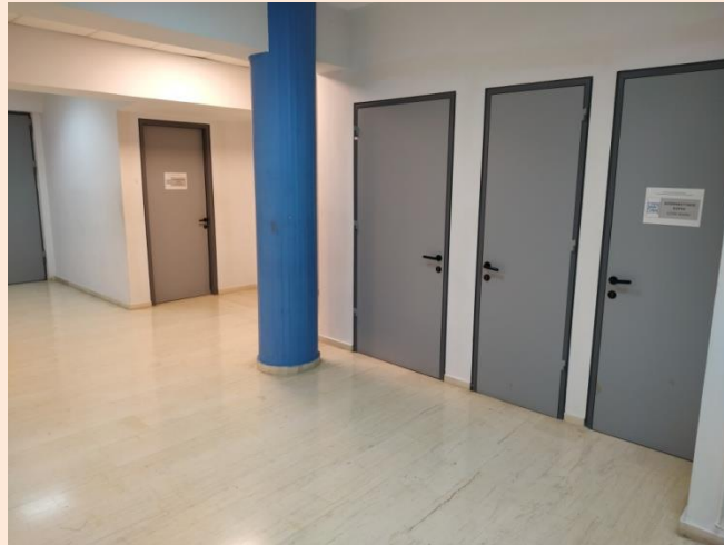
Εικόνα 8: Τηλεφωνικοί θάλαμοι και αποθηκευτικός χώρος
