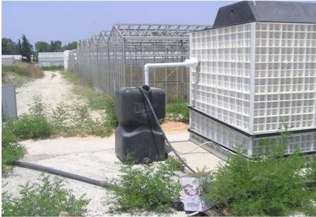
Εικόνα 6. Σύστημα βιολογικής επεξεργασίας με τεχνολογία βιοδίσκων EKOL.
