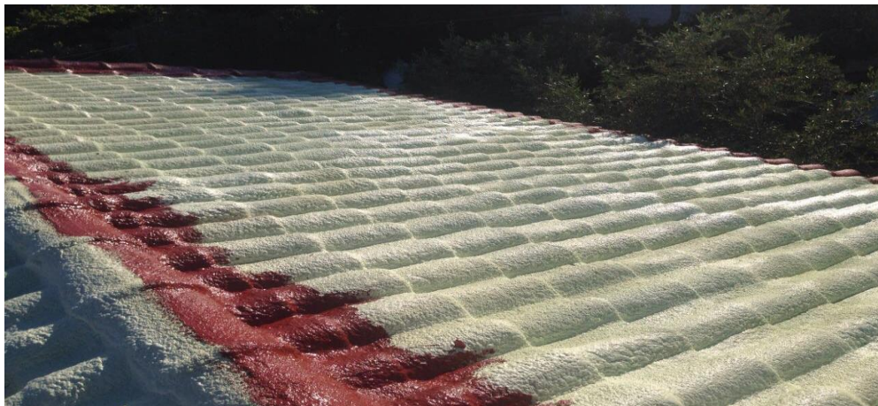
Εικόνα 3.7-Μόνωση, στεγανοποίηση της κεραμοσκεπής
