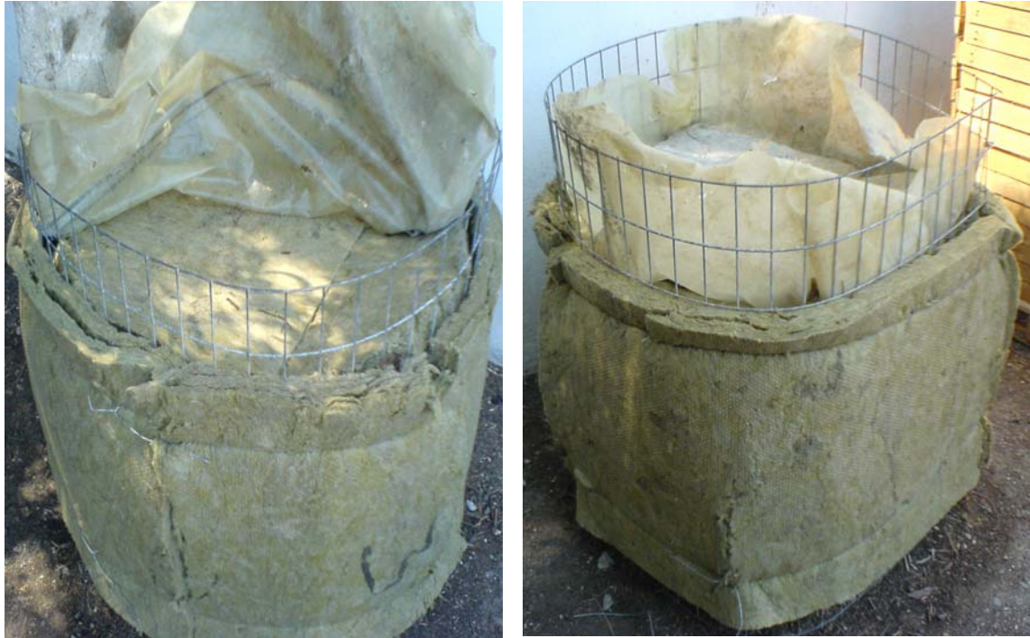
Εικόνα 2.13. Εδώ διακρίνεται ξανά η μόνωση που είχε εφαρμοστεί.
