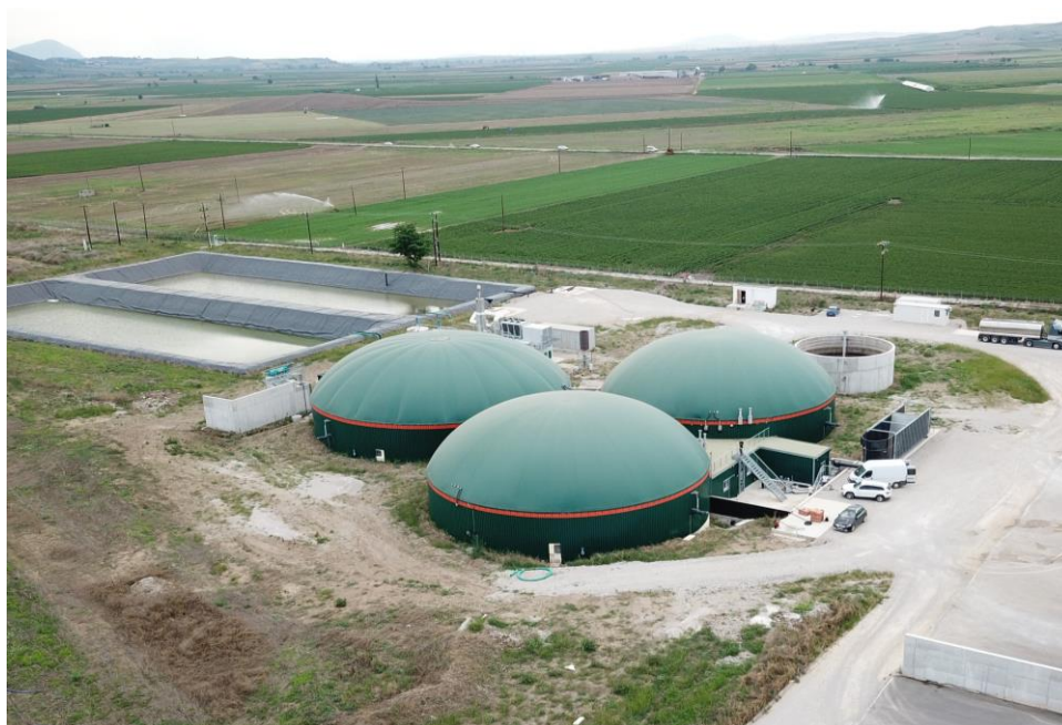
Εικόνα 1.1: Εγκαταστάσεις Φθία Ενεργειακή ΑΕ.
