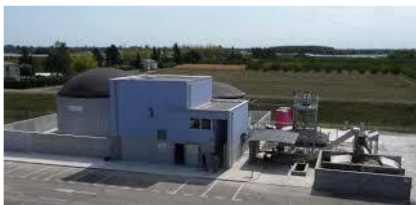
Εικόνα 3.2: Εγκαταστάσεις βιοαερίου BOUER SAS.
