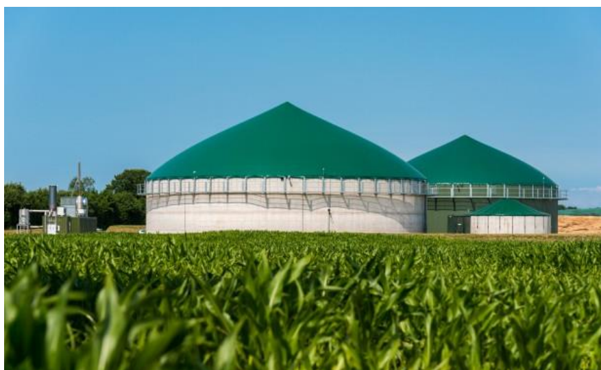
Εικόνα 1.2: Εγκαταστάσεις της Επίλεκτος Βιοαέριο Φαρσάλων ΑΕ.
