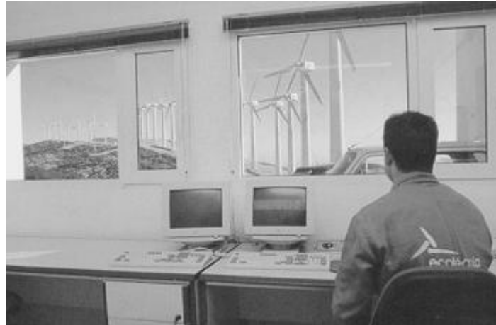
ΣΧΗΜΑ 2.1 Κέντρο ελέγχου αιολικού πάρκου.
