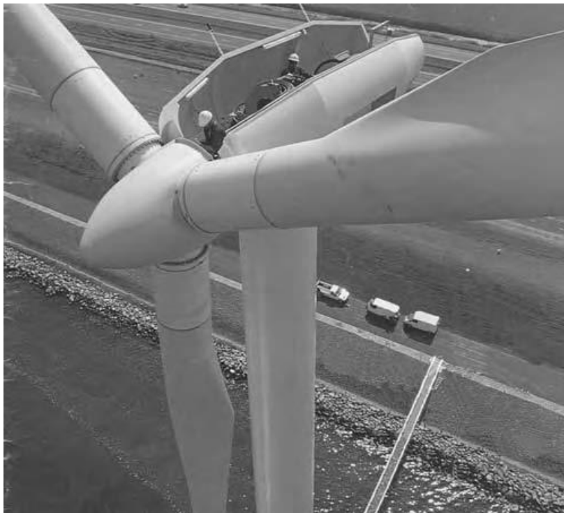
ΣΧΗΜΑ 2.3 Άτρακτος υπό κατασκευή.
