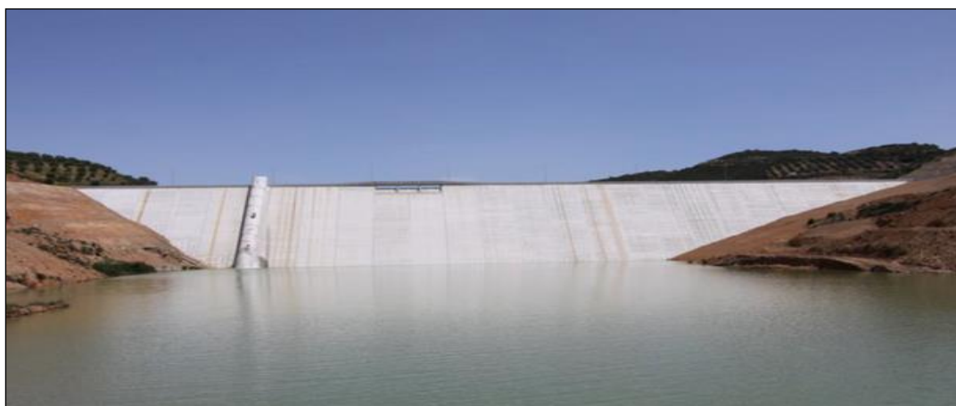
Εικόνα 10: Φράγμα Βαλσαμιώτη Χανίων
