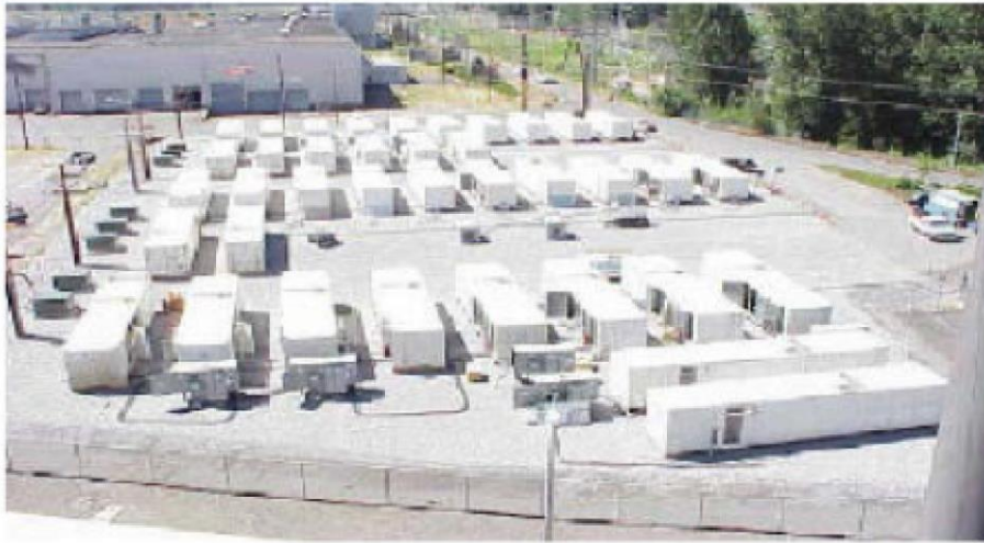
Σχήμα 3.23: Η διάταξη των containers ( 40\text{ MW} για 15\text{ min} ).
