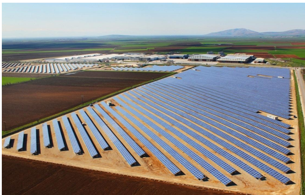
Εικόνα 11. φωτοβολταϊκά σε μεγάλη κλίμακα
