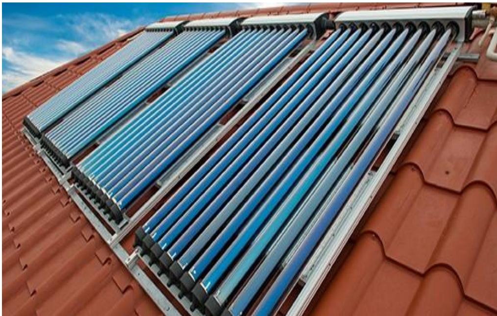
Εικόνα 8. Ηλιοθερμικό σύστημα για οικιακή χρήση με συλλέκτες κενού
