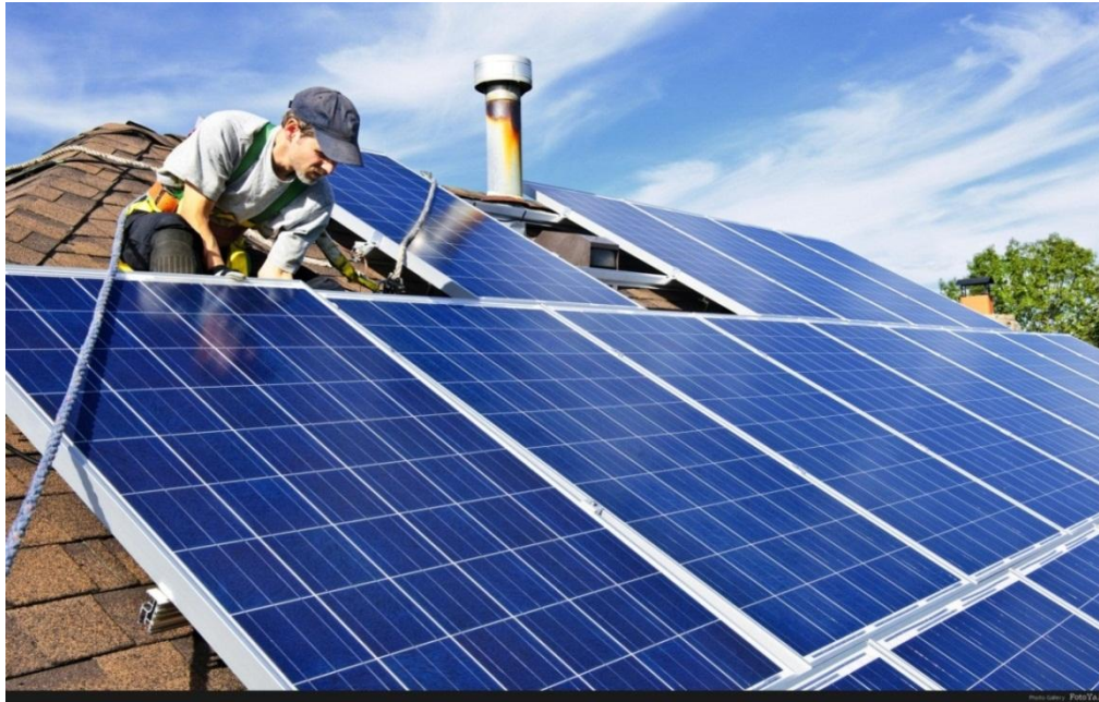
Εικόνα 4. Φωτοβολταϊκά σε στέγη, εγκατάσταση
