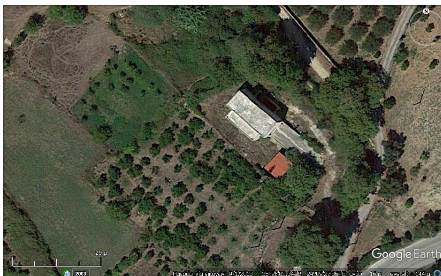
Εικόνα 26 Αεροφωτογραφία Εγκαταστάσεων, Αρμένιοι (Google Earth)
